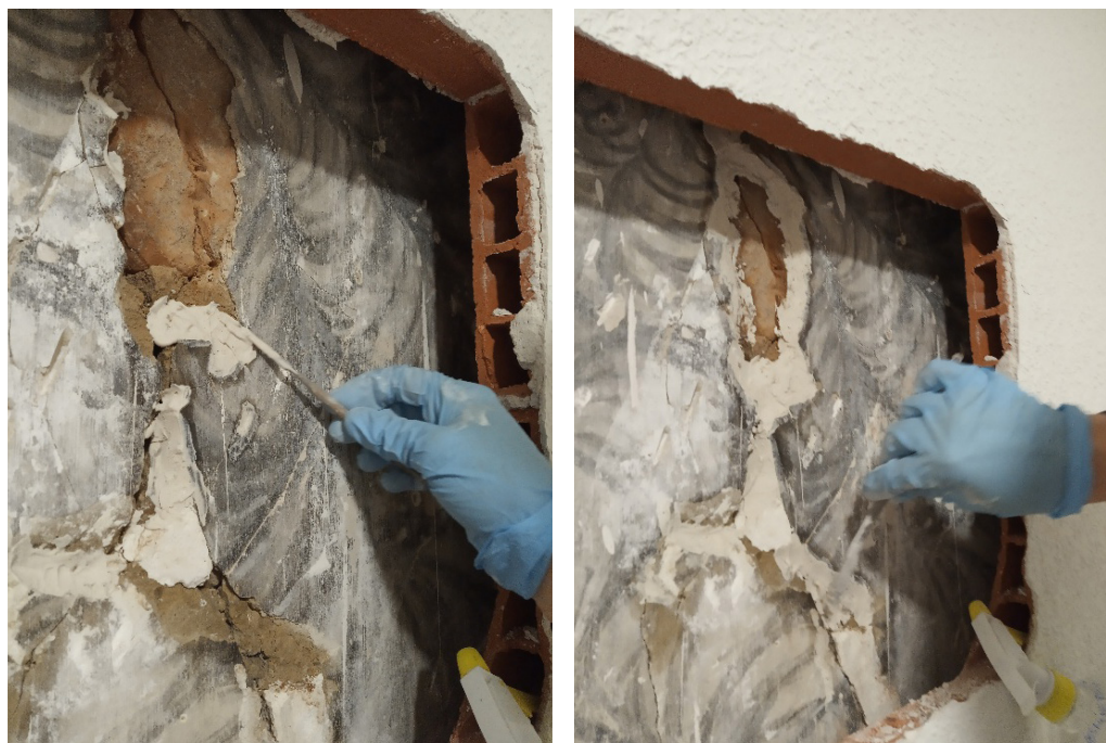
Figura 9. Recercado de grietas con mortero.
