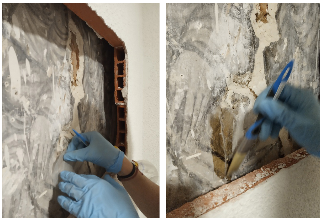
Figura 9. Recercado de grietas con mortero.
