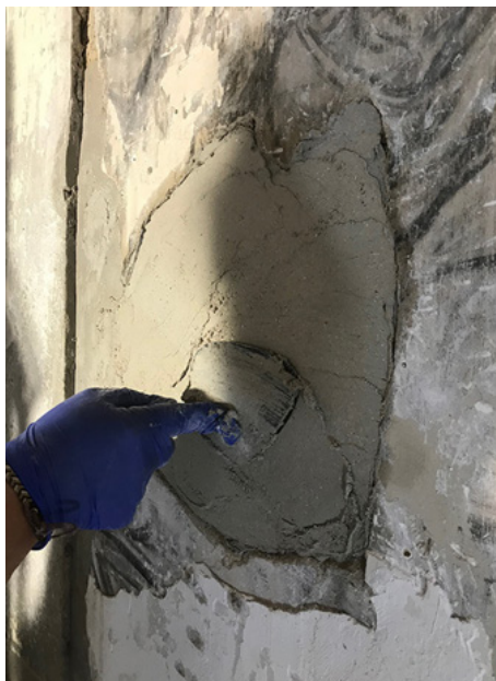
Figura 16. Inyección de cal.
