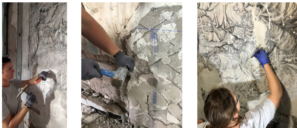
Figura 15. Trabajos realizados de limpieza superficial.
